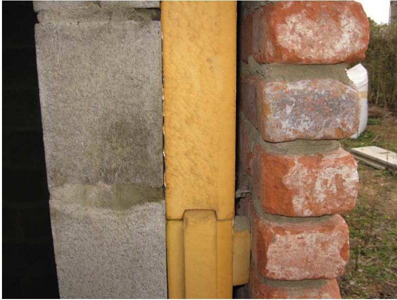
Isolation par l'extérieur : brique, air, isolant et parpaing peu ou pas de placo ici !
