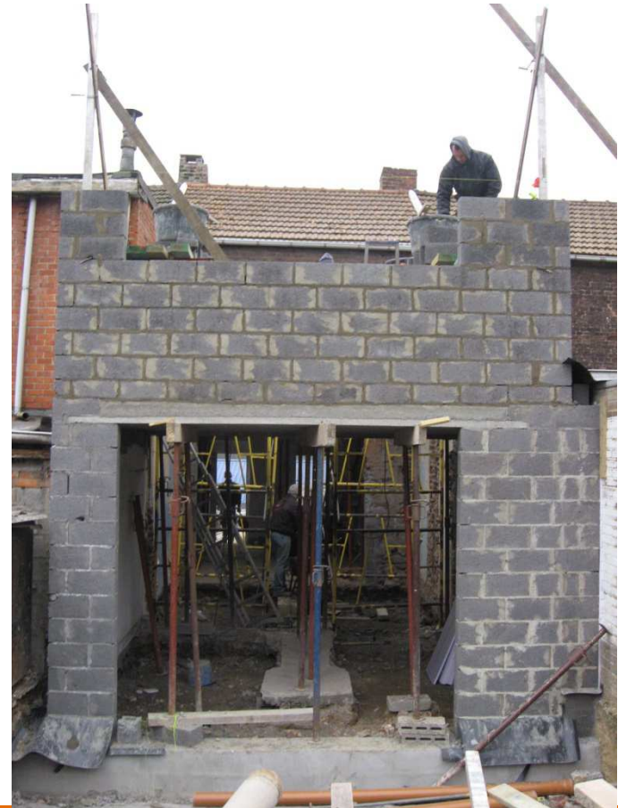
Chantier de Maddy
